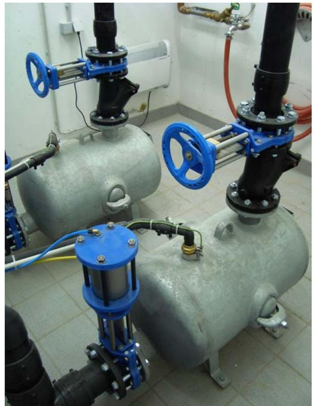
Arbeitsbehälter für wechselweisen Betrieb.
