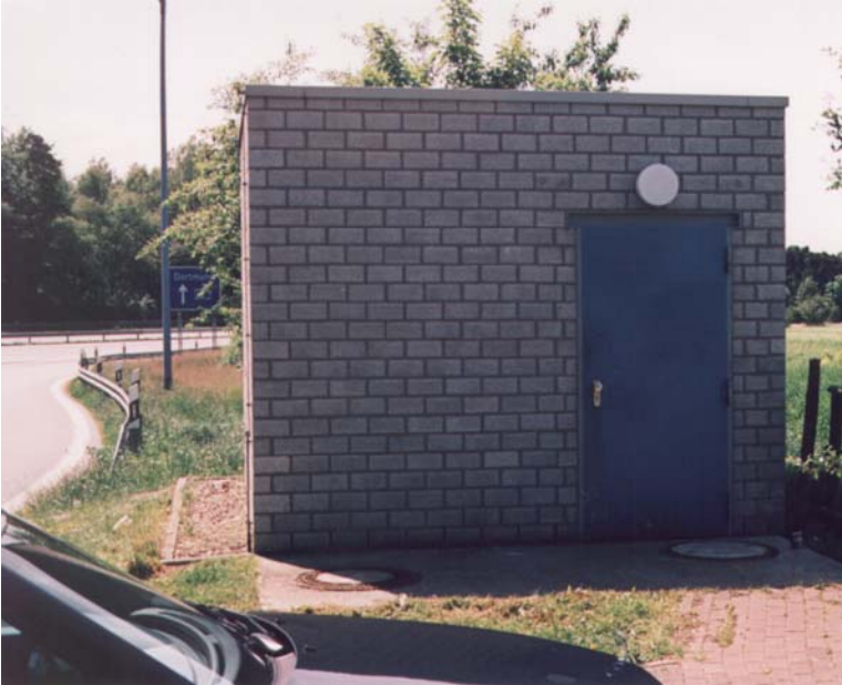
Hochbauteil eines pneumatischen Abwasser-Pumpwerks für einen Autobahnkiosk in Ostwestfalen-Lippe
