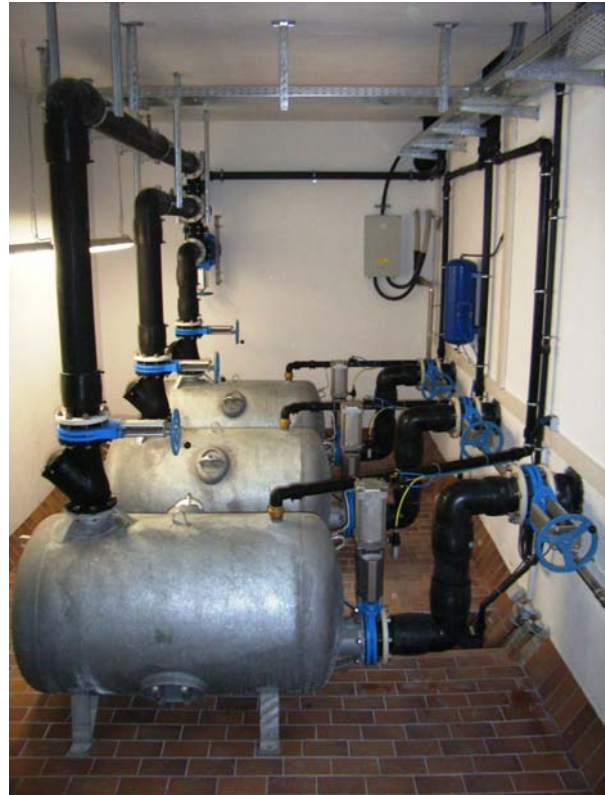
Arbeitsbehälter einer pneumatischen Abwasser-Förderanlage (3-Kessel-Anlage)
