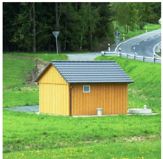
Hochbauteil eines Druckluftpumpwerkes
