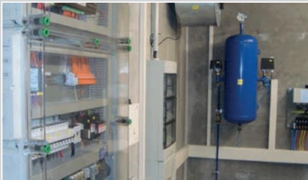
Schaltgehäuse und Steuerluftbehälter
